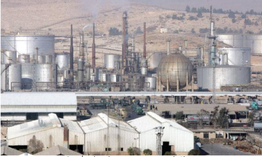
الشكل رقم (١-١): مصفاة البترول الأردنية
